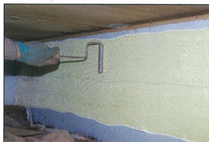
●アラミド繊維シート 貼り付け
