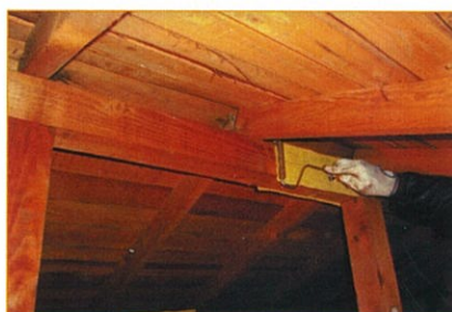
●アラミド繊維シート 貼り付け
